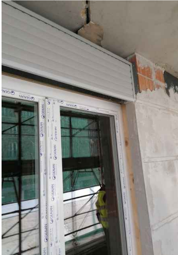
Montaggio di un infisso in Pvc su monoblocco dotato di tapparella in Pvc pesante
