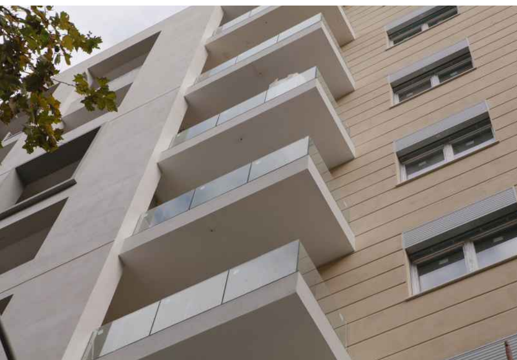
La controparete esterna ultimata e in fase di realizzazione
