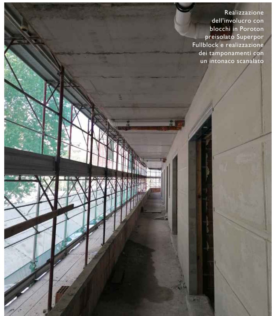
Messa in opera dei solai predalles a travetti bidirezionali con comportamento a piastra, caratterizzati da una lastra inferiore in calcestruzzo come fondo cassero
