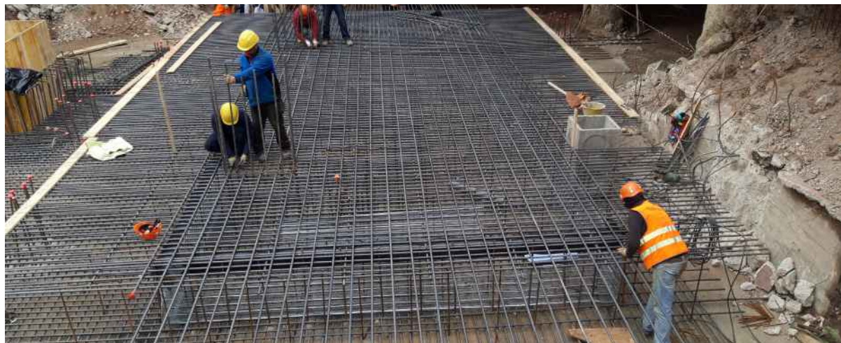
Realizzazione della platea al centro del lotto, spessore di un metro
