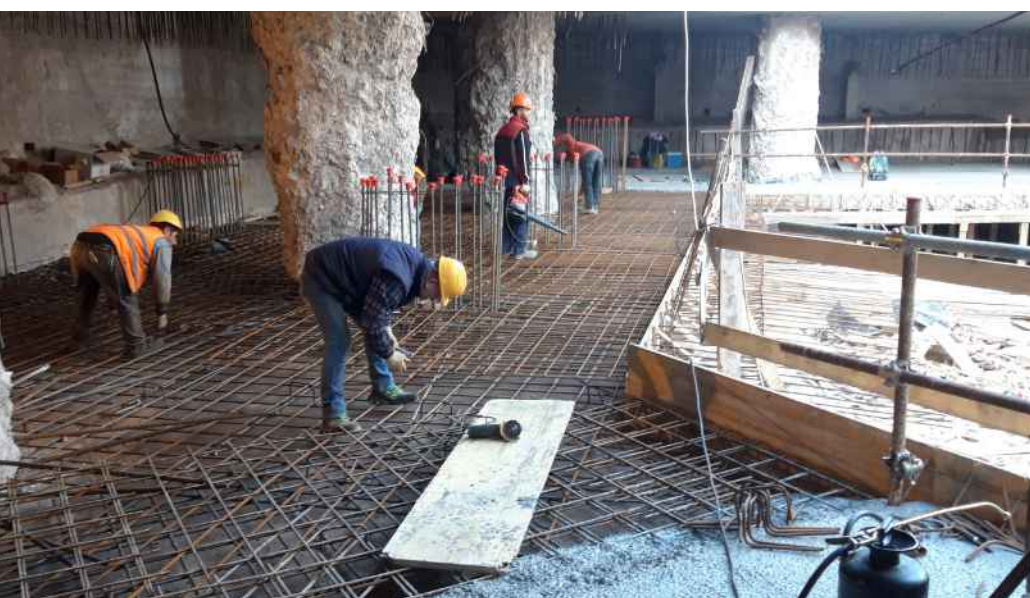
Realizzazione della soletta di contrasto al piano terra. Sotto, realizzazione della soletta di contrasto al primo piano interrato
