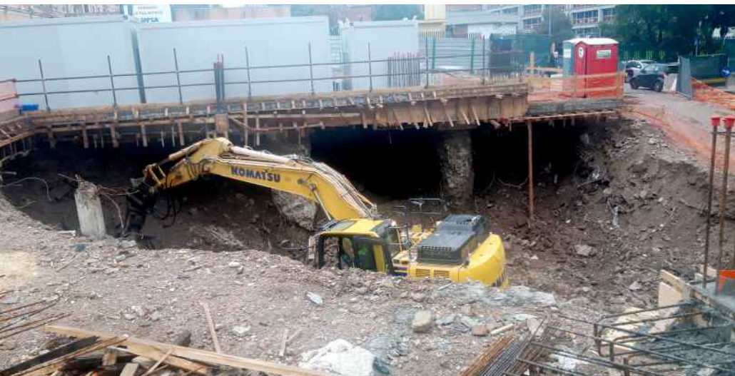
Realizzazione dei pilastri sacrificali, posizionati nella parte eccedente a quella strettamente necessaria al palo di fondazione. Sopra, realizzazione dello scavo
