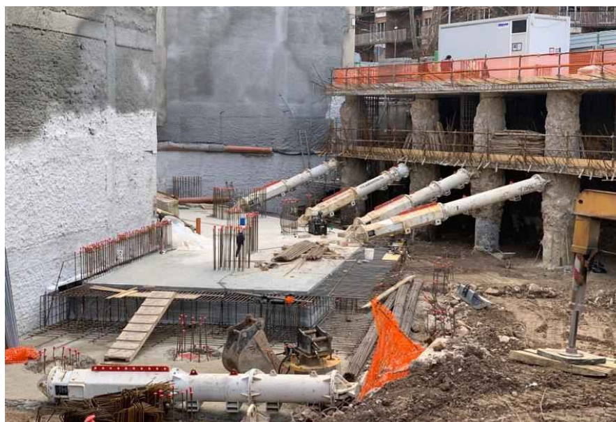
Realizzazione dei puntellamenti con puntoni idraulici telescopici che poggiano sulla platea di fondazione al centro del lotto
