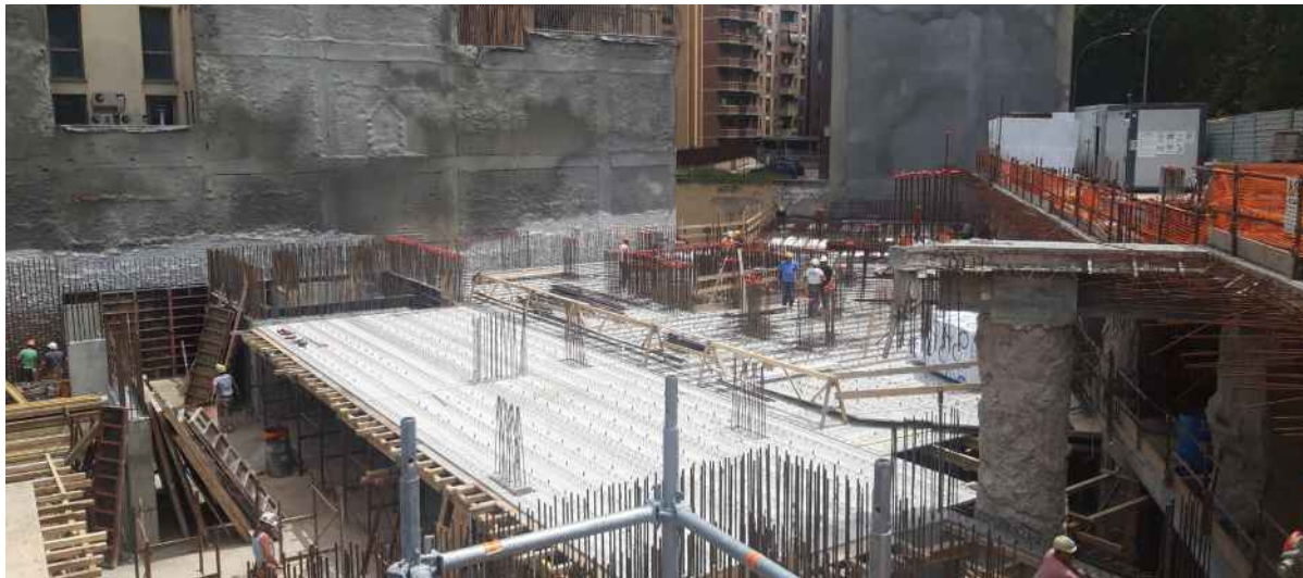
Realizzazione del solaio a piastra come fondo cassero
