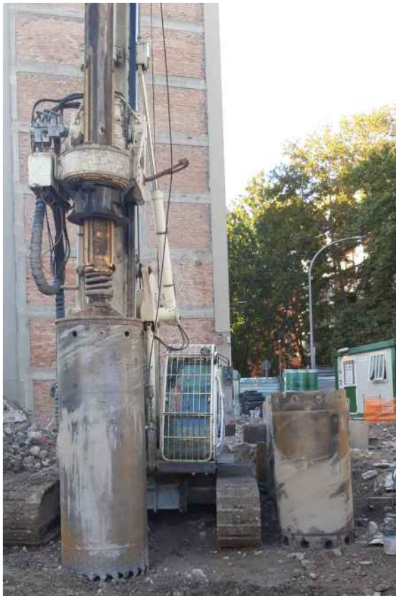
Realizzazione dei pali di fondazione integrativi a quelli esistenti
